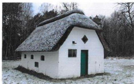
Udhuset set fra sydøst
